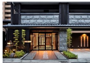
プレサンス ロジエ 烏丸五条 (京都市)
