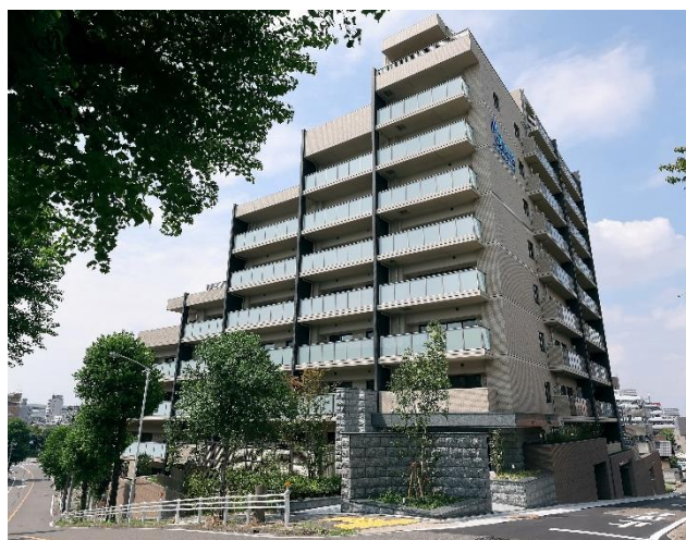
ロジエ白壁ヒルズ（名古屋市）
