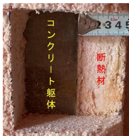
断熱材施工の断面
