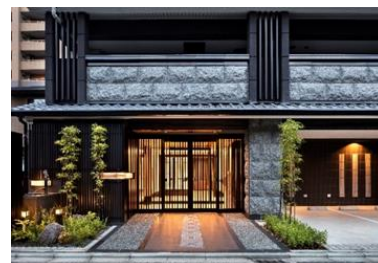
プレサンス ロジエ 烏丸五条 (京都市)
